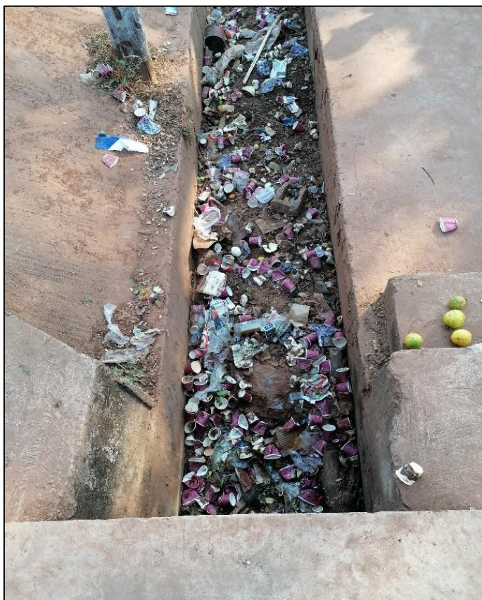
Photo 38: Un des modes d'évacuations des eaux usées et des ordures dans une canalisation à proximité de la gare routière de Sédhiou
