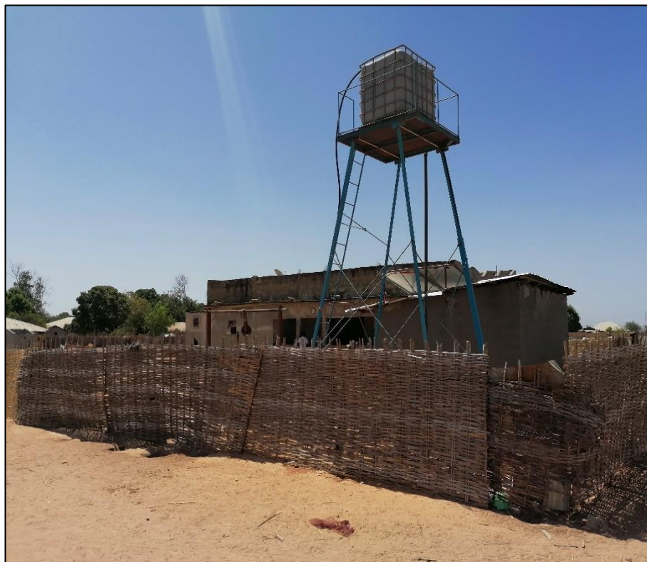
Photo 37: Raccordement d'un puits à des panneaux solaires dans le village de Bloc Sefa
