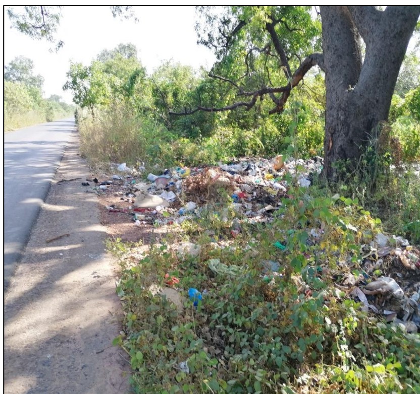
Photo 39: Évacuation des ordures ménagères le long de la RN 12
