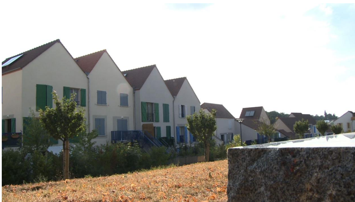
Illustration 7 Tranches 1 et 2, architecte Lucien Kroll (photographie de Danièle Zetlaoui)
