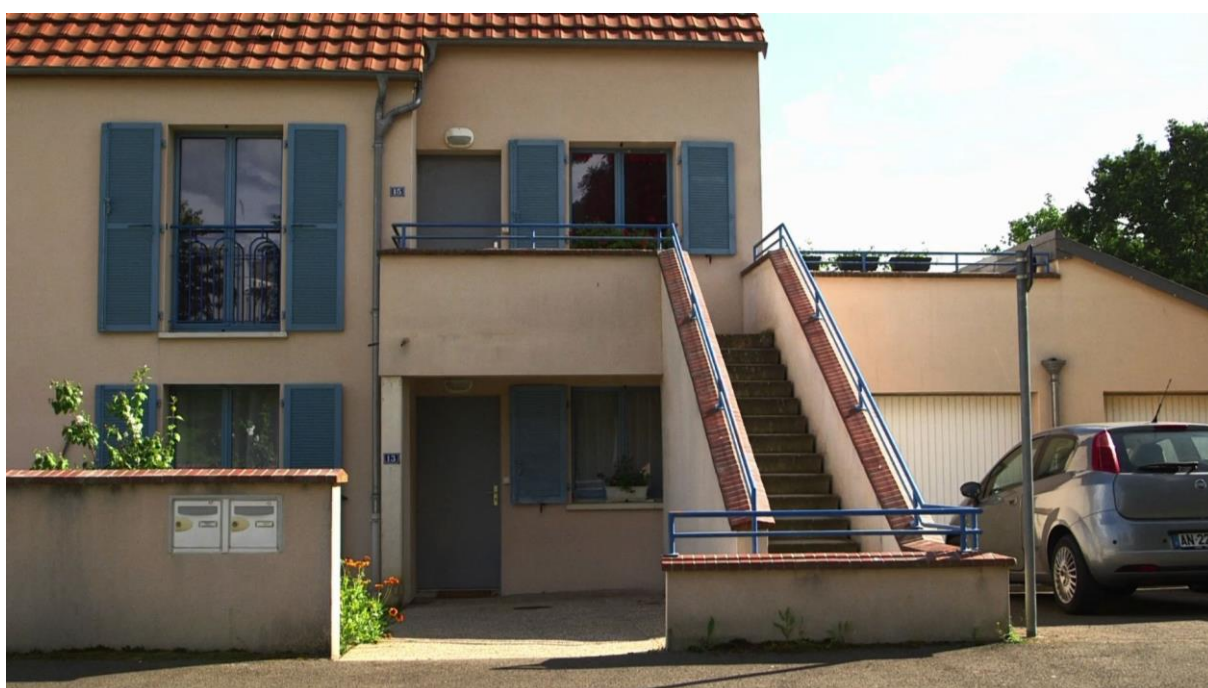
Illustration 9 Tranche 4, architecte Gilles Pessard (photographie de E. Balteau)
