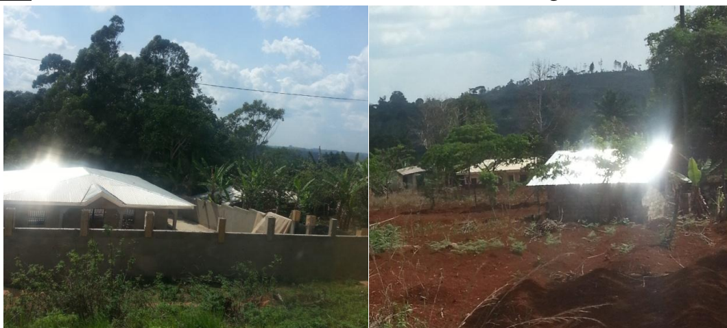
Figure 25 : tôles ondulées en aluminium neuves (ville de Baganté, 27° C)
