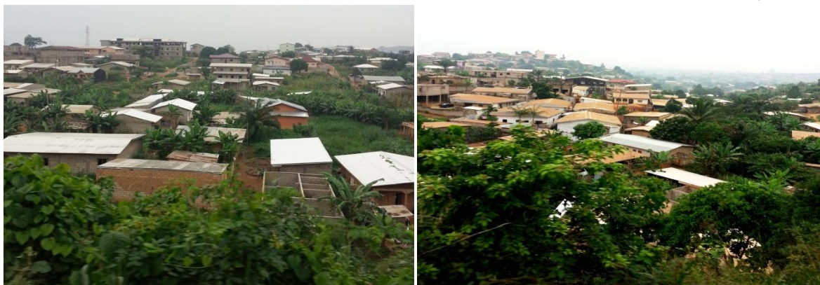
Figure 27 : altération de la tôle ondulée en aluminium et de la tôle en acier galvanisé
