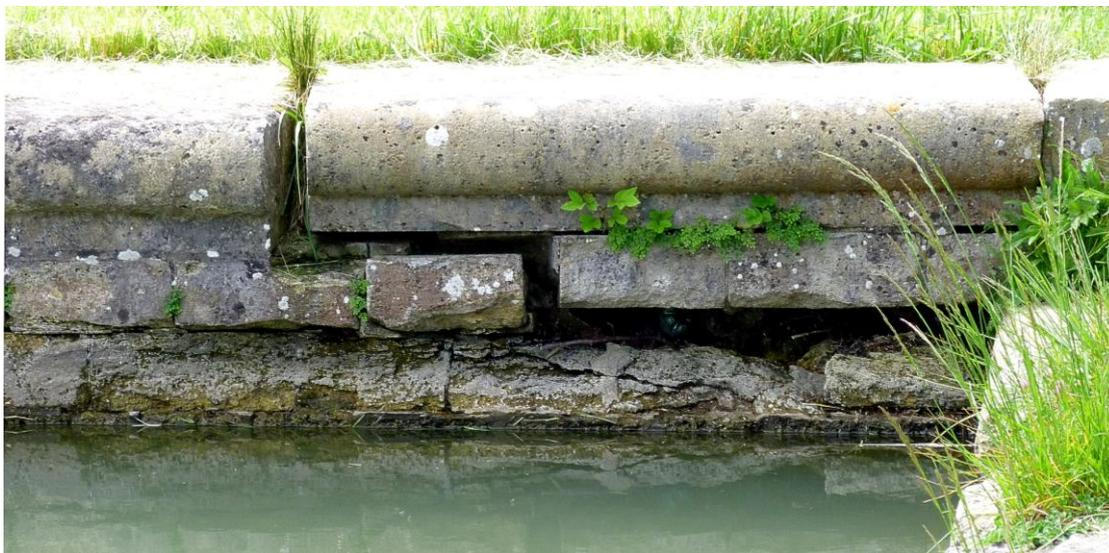
Figure C1 – Maçonnerie endommagée du Grand Canal
