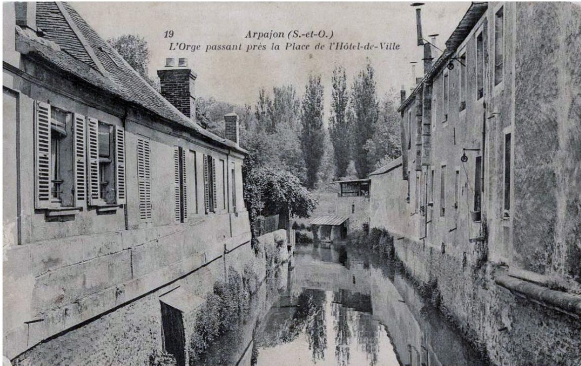
Ci-dessus, l'Orge passant à Arpajon, encaissée entre deux murs d'habitations. Nous remarquons une multitude de tuyaux servant à l'évacuation des eaux usagées qui font saillie au-dessus de la rivière, ce qui tend à prouver l'usage du cours d'eau comme d'un égout. Nous distinguons également sur le bâtiment de droite un seau rattaché à une poulie, lequel sert très certainement au puisage de l'eau domestique. Enfin, deux lavoirs individuels sont également visibles.
