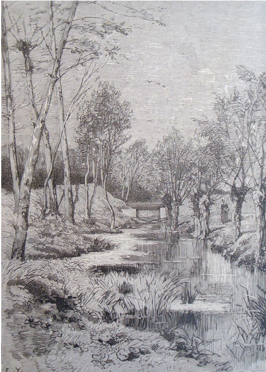
Cette illustration représente l'Orge et le siphon de la Vanne moins de dix ans après l'établissement de ce dernier. Nous pouvons distinguer au centre du dessin, jeté sur la rivière, un gros tube posé sur deux culées qui semblent être en maçonnerie. C'est grâce à cette construction que les eaux de la Vanne franchissent l'Orge pour se diriger vers Paris.
