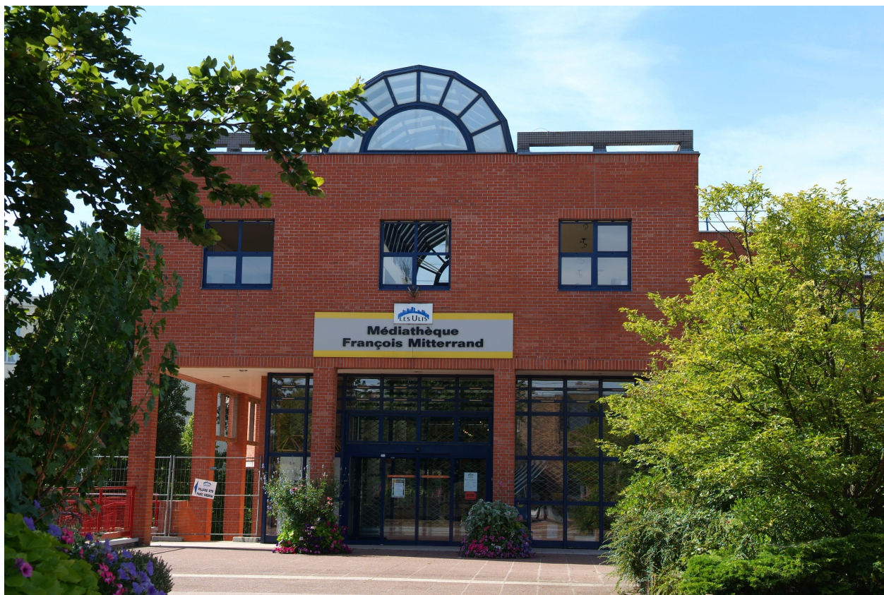
Médiathèque François Mitterrand, 2007. Photo : Galère Patrick.
