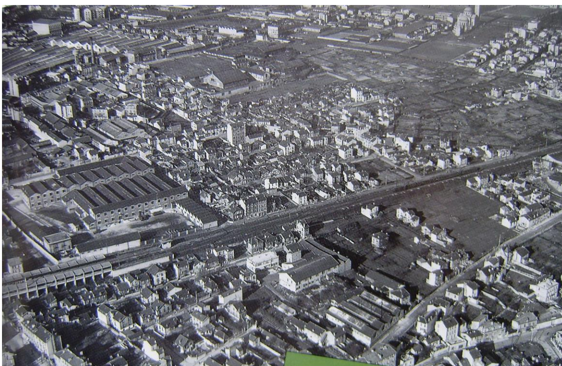
Document 43 : Vue aérienne d' Arcueil, sur le tracé de la future autoroute
