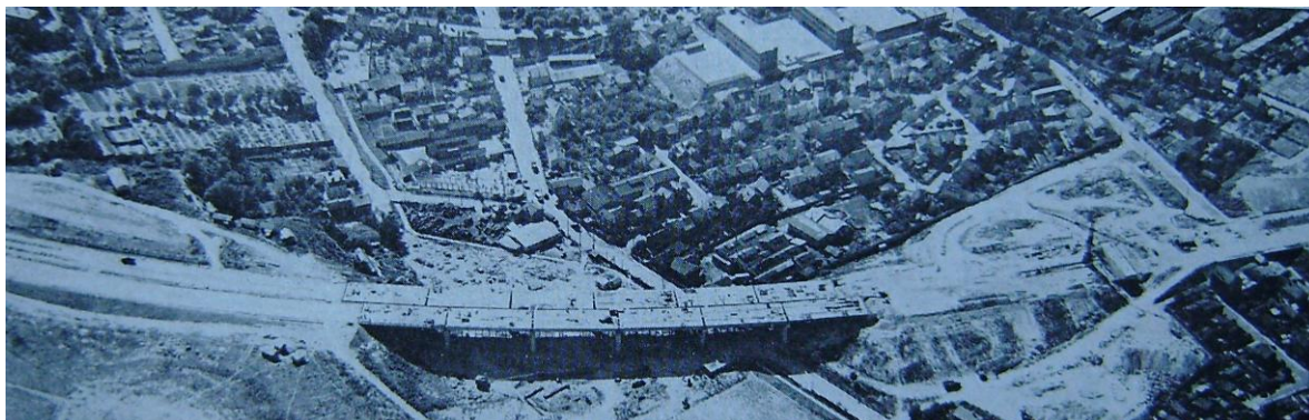
Document 61 Le chantier de construction du viaduc d'Arcueil Photo Durandaud - Brochure ITBTP p. 671
