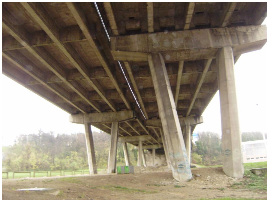
Document 66 Le viaduc d'Arcueil aujourd'hui, vu du dessous Cliché de l'auteur 9.12.2008 On peut voir le caractère double de ce viaduc, porté par des piles alternées.
